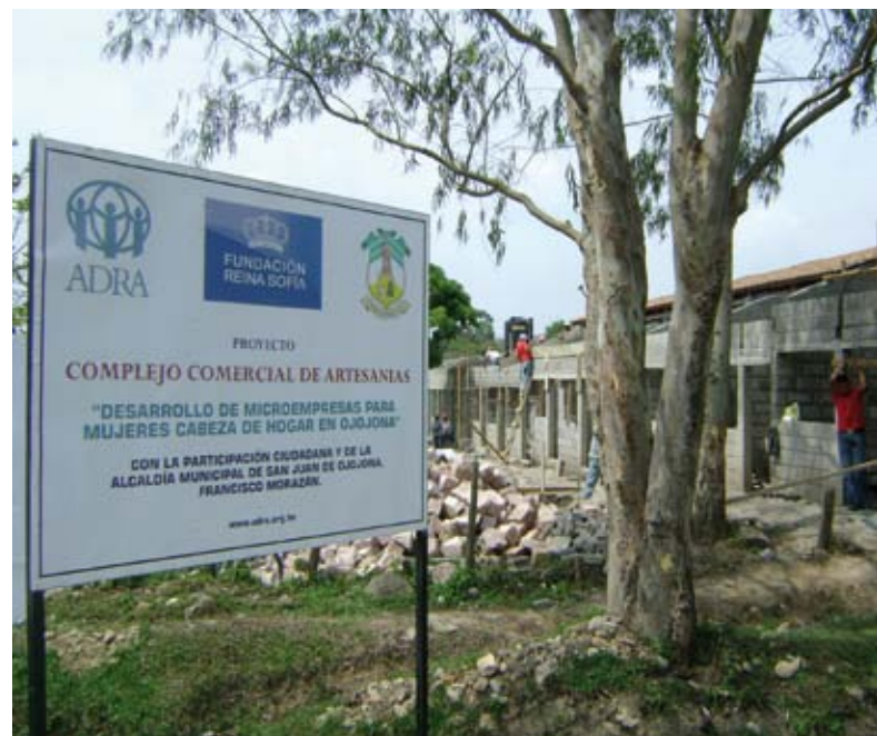
Cartel anunciador de las construcciones
