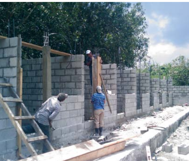
Construcción del complejo comercial de artesanías
