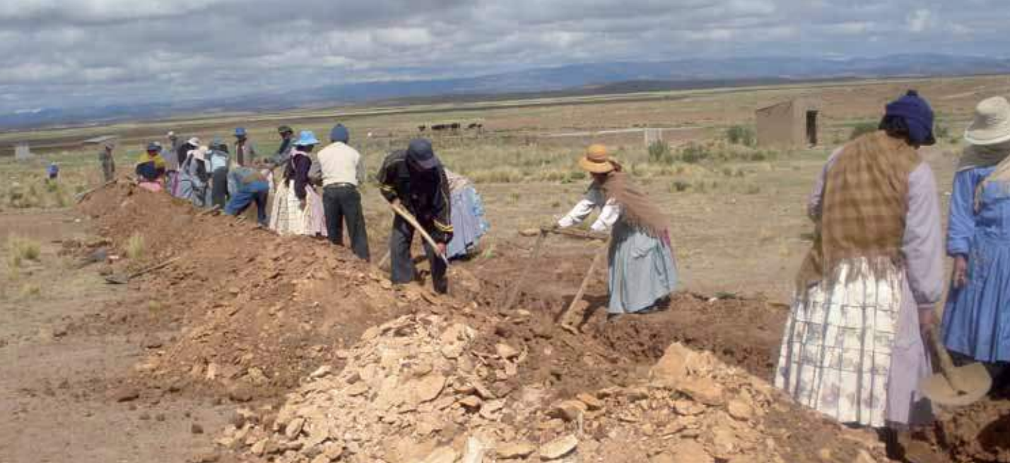
> Excavación y colocación de tuberías para la línea de inducción.
